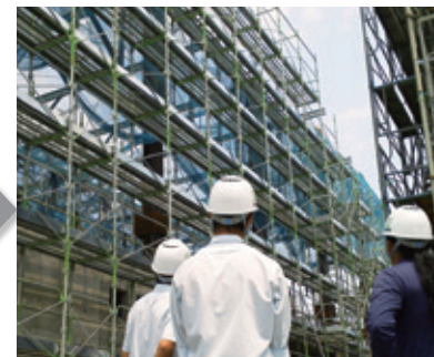
新商品の開発では施工現場と製造両者の意見を取り入れながらテストを複数回実施します
